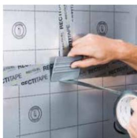
**Etape 2:** appliquez Rectitape® en exerçant une pression à l'aide d'un outil adapté\* et à une température idéale à partir de -10 °C. Appuyez bien sur la bande pour une adhérence parfaite.
