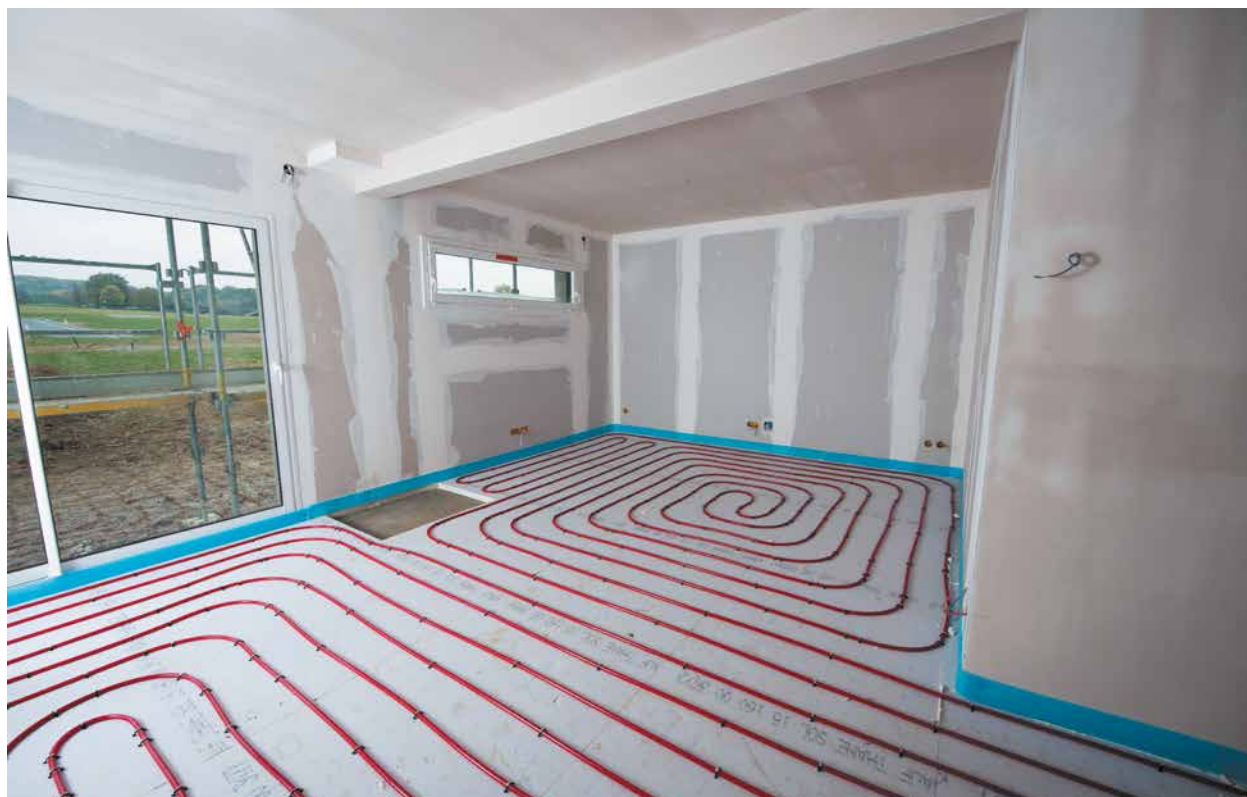
Maison Optima - Hagental le bas (68) - Mise en œuvre de la bande de rive Knauf Pérимousse et du plancher chauffant
