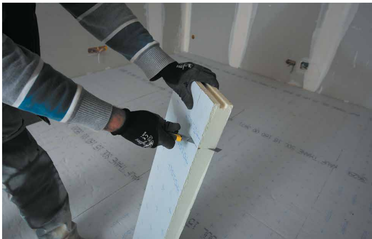
Maison Optima - Hagental le bas (68) - Découpe des panneaux Knauf Thane Sol
