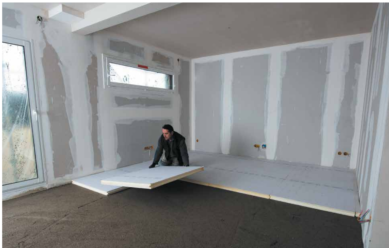
Maison Optima - Hagental le bas (68) - Mise en œuvre des panneaux Knauf Thane Sol sur la couche de ravaillage
