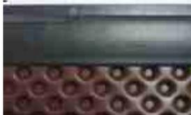
**Finition bord inférieur** En partie basse, la nappe s'arrête au bord inférieur des fondations.
