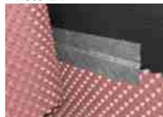
**Finition bord supérieur** Mettre en place le profilé pour recouvrir la partie haute de la nappe. Il se fixe mécaniquement dans les perforations prévues à cet effet. (photo 3)
