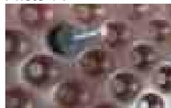
Chevauchement des lés : par emboîtement des alvéoles sur 10 à 15 cm minimum. Eviter les zones de chevauchement vertical proches des angles.
