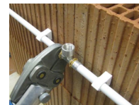
TUB-RING - vue en situation avec pince à sertir
